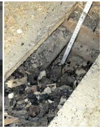
Fehlboden mit Schlackefüllung
