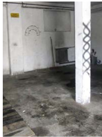
Ölverunreinigter Betonboden
