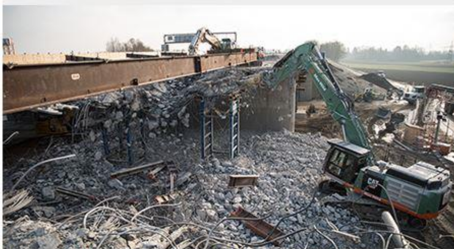
Die Bauarbeiten teilen sich in mehrere Bauabschnitte auf
