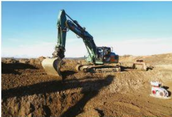
Die Verlegung der Stahlbetonrohre mit einer Gesamtlänge von circa 1 km wurde in die Hände des Bauunternehmens Max Wild gelegt.
