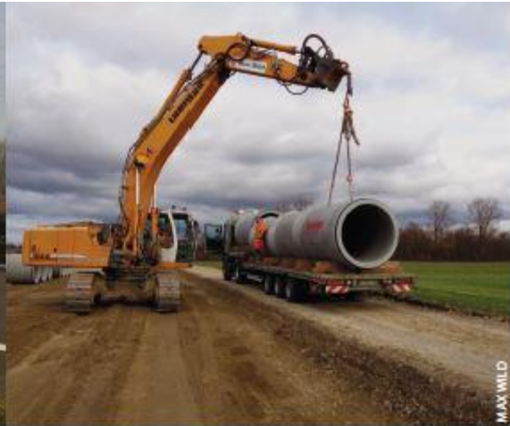
Um den Ort Kirchdorf an der Iller bei extremen Niederschlagsereignissen besser schützen zu können, wird derzeit ein zweiter großer Kanal zur Ableitung größerer Wassermengen gebaut.
