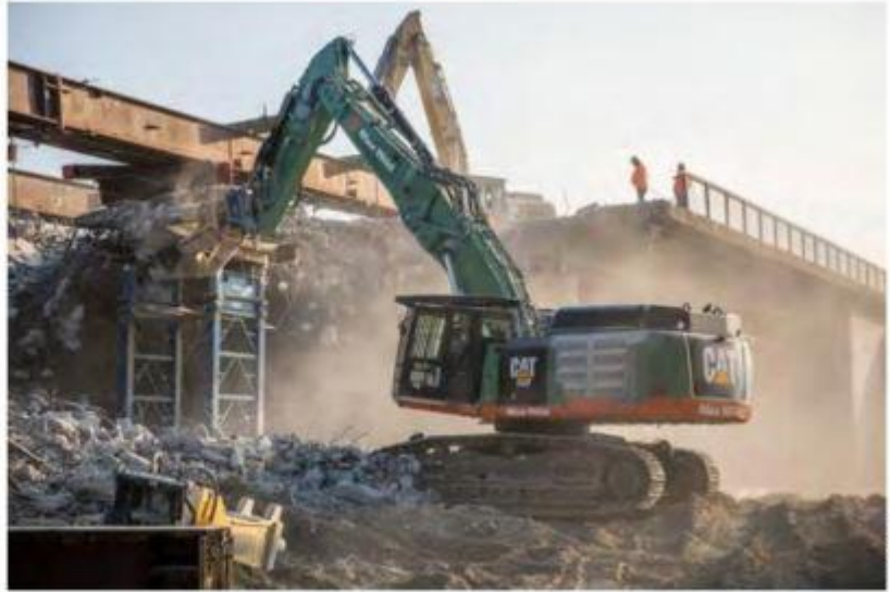
Insgesamt wurden durch die Firma Max Wild bereits sechs Brücken an der A99 abgerissen, drei sollen noch folgen.
