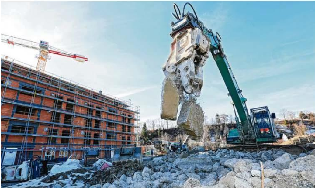
Zwischen Abbruch (rechts) und Neubau (links): Auf dem früheren Gewerbegebiet in der Füssener Straße werden Wohnhäuser gebaut.
