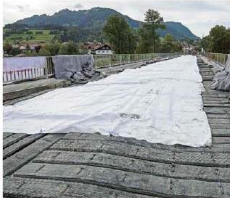
Kreisstraßenbrücke zwischen Blachach und Burgberg.
