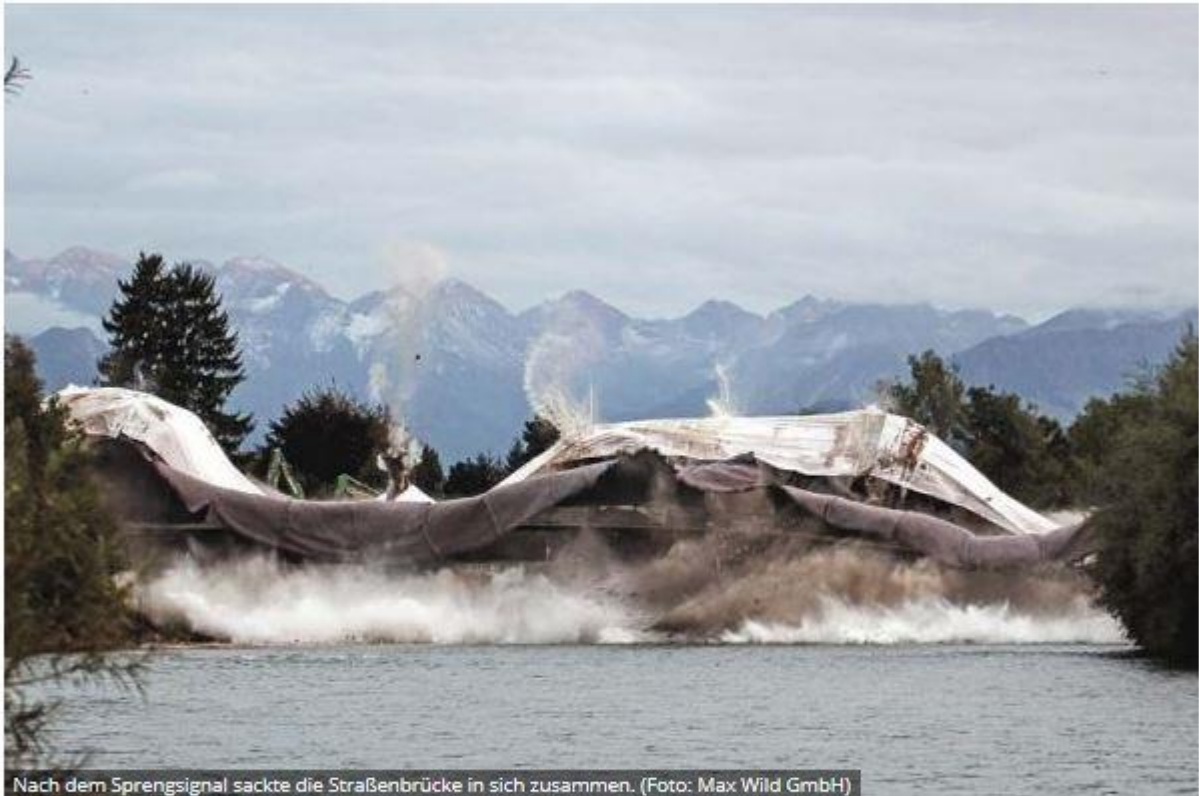
Nach dem Sprengsignal sackte die Straßenbrücke in sich zusammen. (Foto: Max Wild GmbH)
