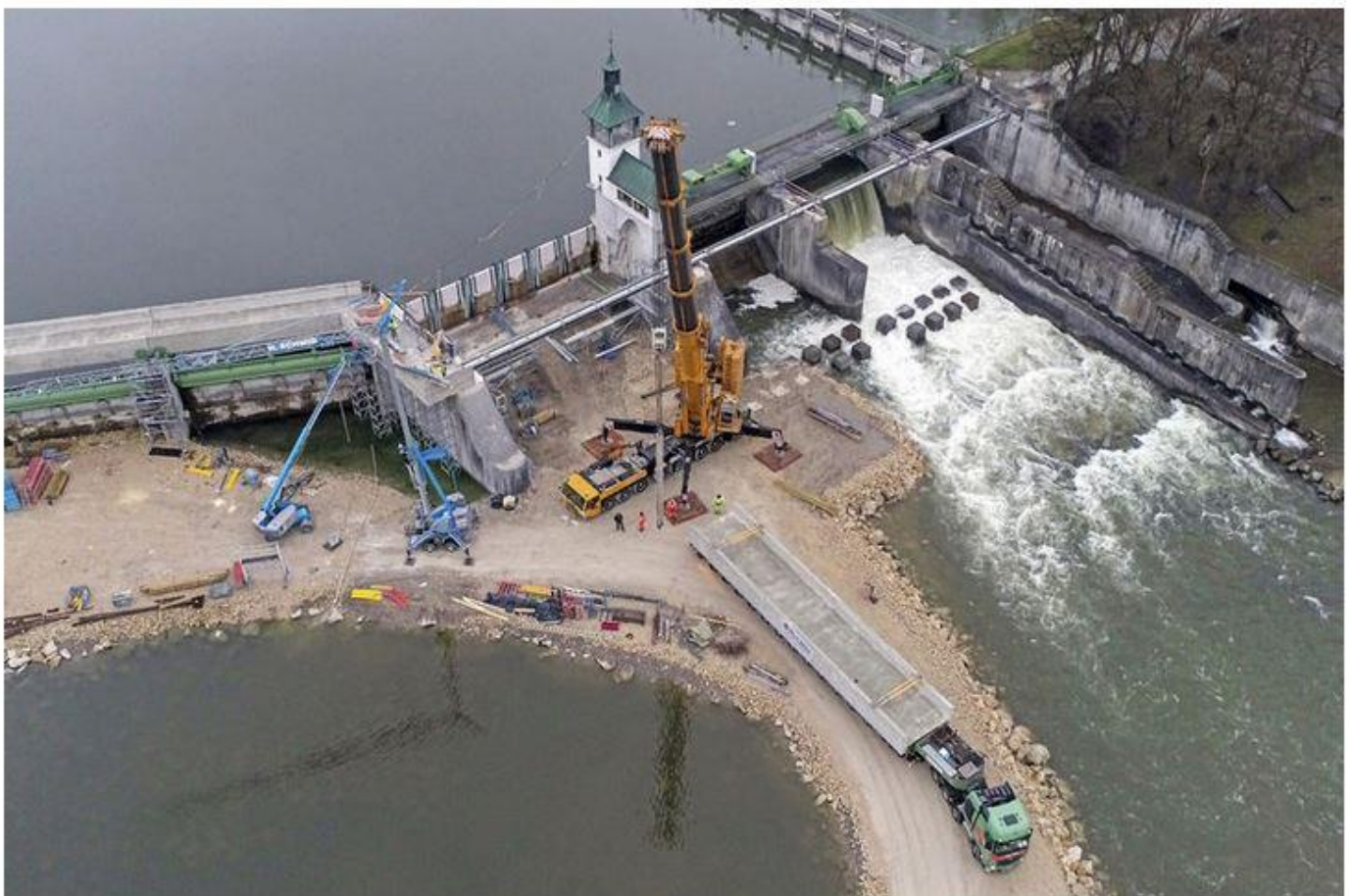
Ein Spezialkran fügt die Betonelemente für den Fußgängersteg ein. Foto: Max Wild GmbH
