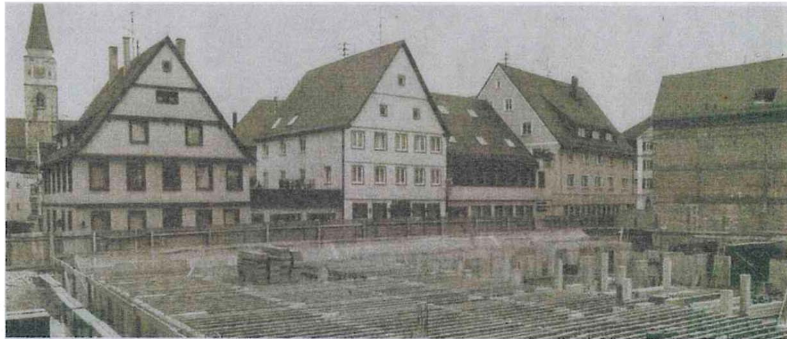
Im Juni 1986, als die Tiefgarage von Bucks Höfle betoniert worden ist, gab es diesen freien Blick auf die Häuserzeile vom Buck'schen Eckhaus über „Pfauen“ bis zur Volksbank, die jetzt abgerissen wird. Rechts Fässer vor der Küferei Maichle um 1900.
