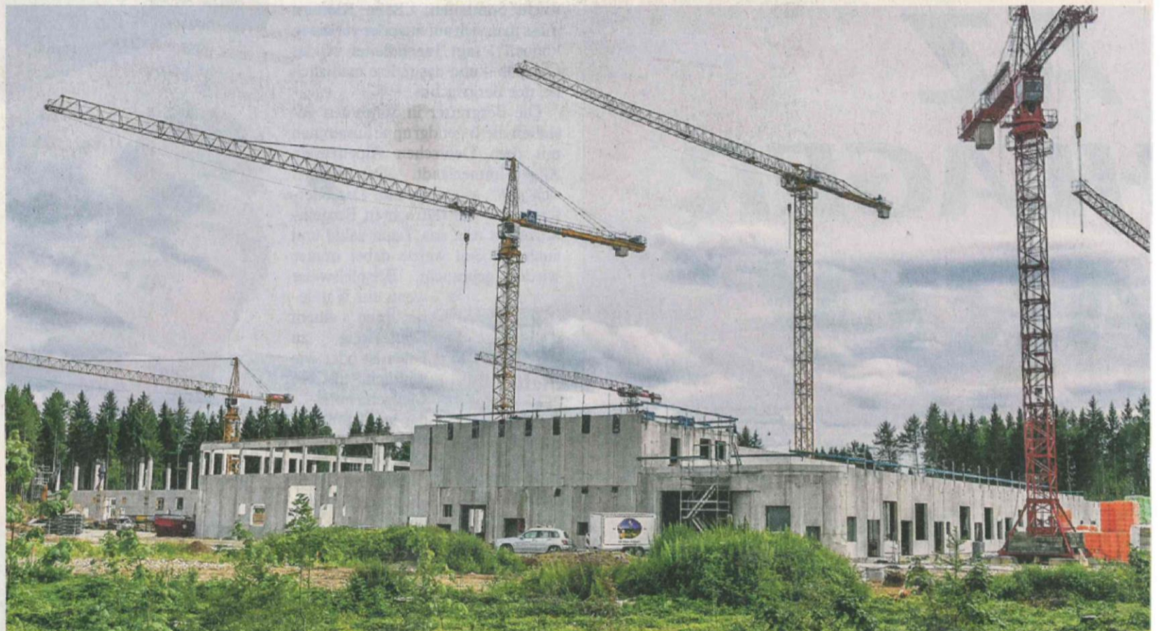
Das künftige Zentralgebäude des Centerparks Allgäu nimmt bereits Gestalt an. Ende 2018 soll der Ferienpark zwischen Leutkirch und Altusried eröffnen. Fotos: Ralf Lienert
