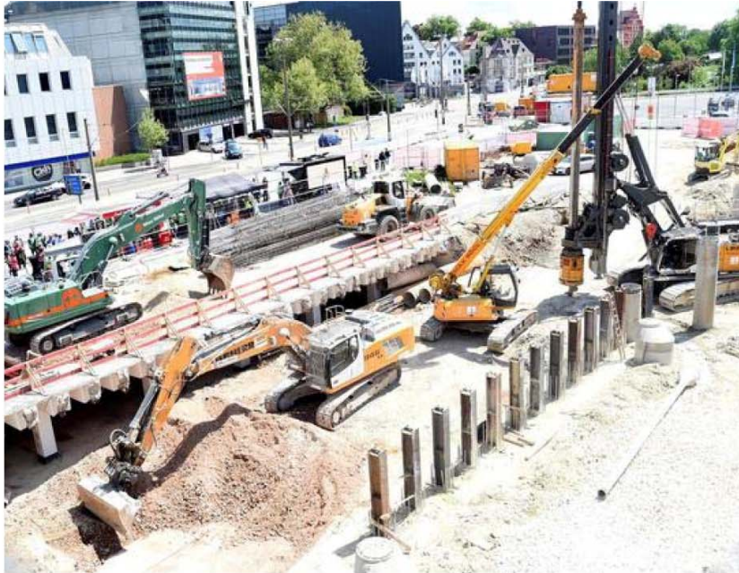
Die Arbeiten zum Umbau des Bahnhofsvorplatzes in Ulm laufen auf Hochtouren.(Foto: Andreas Brücken)
