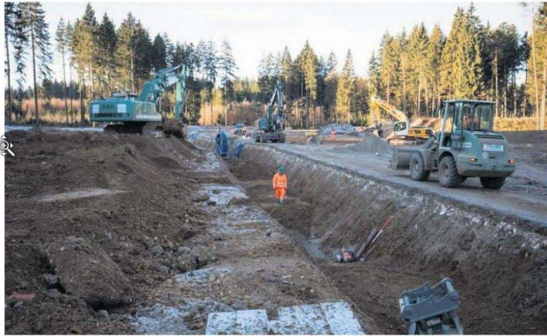
Voll im Zeitplan liegen die zur Zeit laufenden Maßnahmen auf dem Center Parcs-Gelände zwischen Leutkirch und Altusried.
