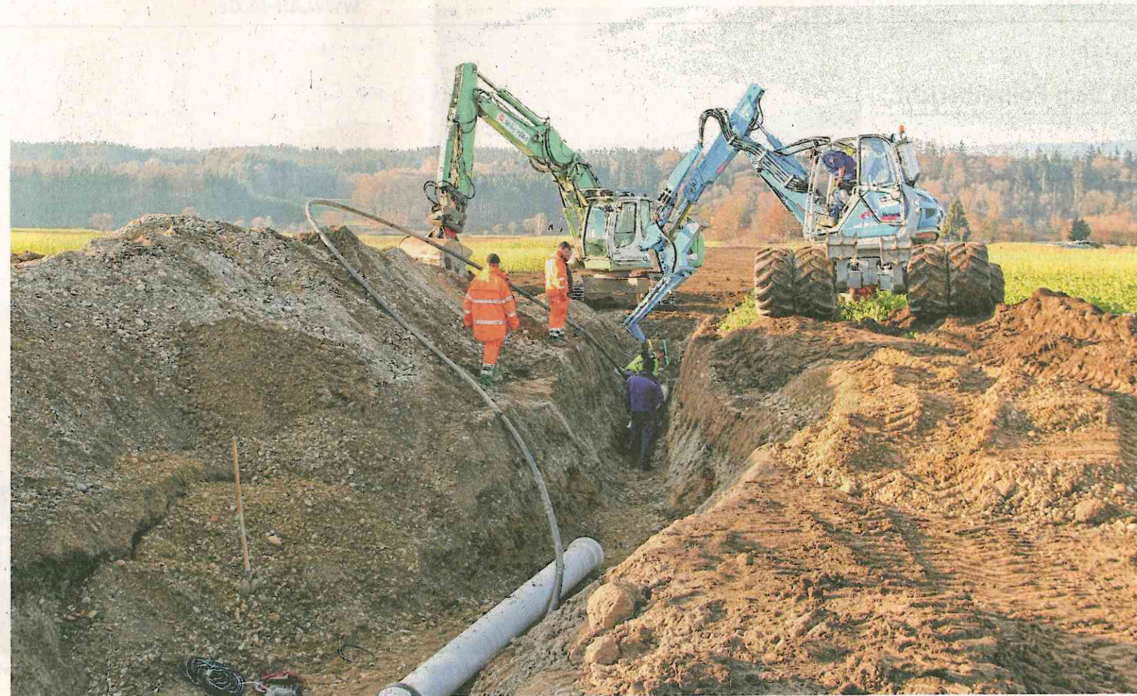
Zwischen Erolzheim und Kirchdorf wird derzeit die Abwasserdruckleitung für den Anschluss an das Gruppenklärwerk in Heimertingen verlegt. Unser Bild entstand am Ortsausgang von Erolzheim in Richtung Dettingen. Foto: Tobias Rehm
