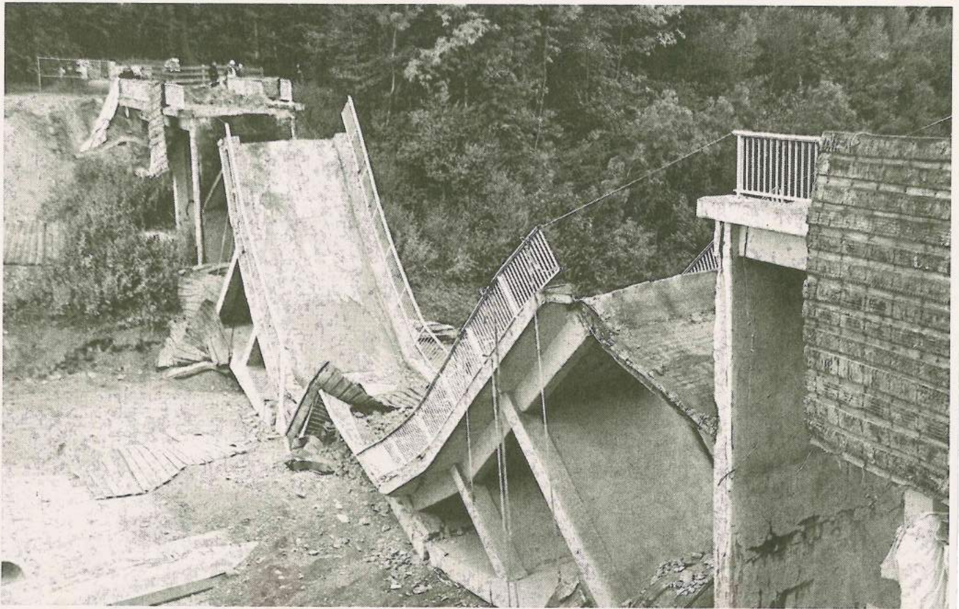
Das 1 m hohe Fallbett aus nichtbindigem Material unter der Brücke wurde nach der Vollsperrung der Autobahn (10 Std. vor der Sprengung) angebracht. FOTO: REISCH SPRENGTECHNIK
