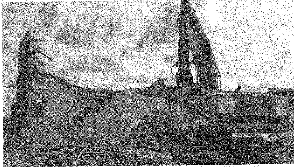
Massen von Beton haben Mitarbeiter der Firma Max Wild in Wetzlar bewegt. FOTO: MAX WILD GMBH
